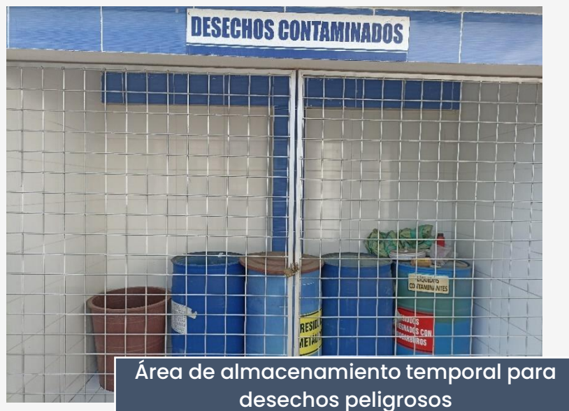
Fotografía 13 - Área de almacenamiento temporal para desechos peligrosos
