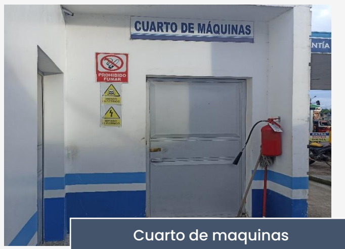
Fotografía 8 - Cuarto de maquinas
